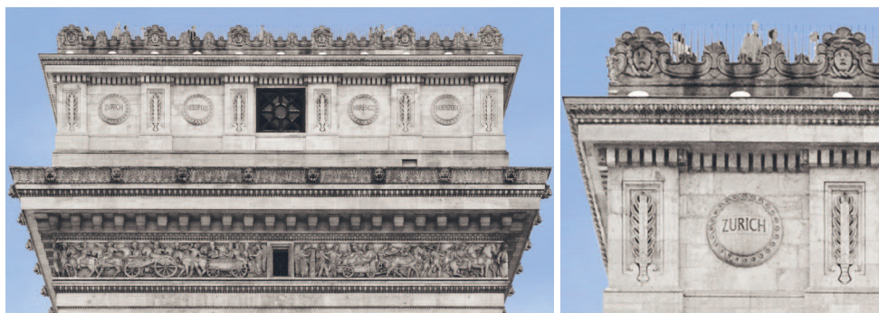
Abb. 1 (inkl. Vergrößerung): Der Name «ZÜRICH» befindet sich auf der Innenseite der Attika des Triumphbogens an der nordöstlichen Pfeilerseite (unter dem Bogen an der Avenue de Wagram) 2
